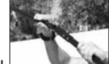
**Étape 11:** Si votre abri est livré avec une paroi murale complète, préparez un autre assemblage droit. Insérez cet assemblage dans le manchon correspondant sur la partie inférieure de la paroi murale. Ensuite, fixez la rallonge d'auvent incluse sur le bras d'auvent en le glissant sur l'extrémité (figure L). Comme précédemment, fixez l'assemblage droit sur la rallonge (figure K).
